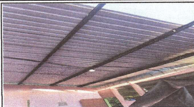
Foto 1: Sustitución de lámina, por lámina troquelada aluzinc calibre 26 Sustitución de capote de lámina para lámina acanalada Sustitución de elementos de fijación
