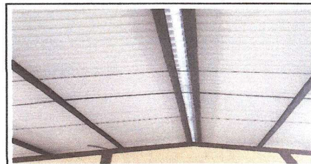
Foto 6: Sustitución de lámina, por lámina troquelada aluzinc calibre 26 Sustitución de capote de lámina para lámina acanalada Sustitución de elementos de fijación
