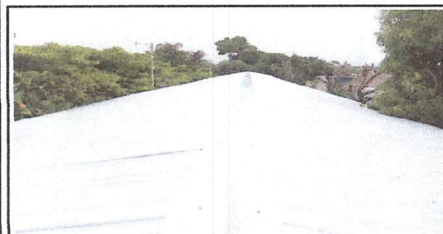
Foto 5: Sustitución de lámina, por lámina troquelada aluzinc calibre 26 Sustitución de capote de lámina para lámina acanalada Sustitución de elementos de fijación
