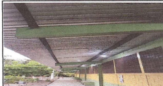
Foto 4: Sustitución de lámina, por lámina troquelada aluzinc calibre 26 Sustitución de capote de lámina para lámina acanalada Sustitución de elementos de fijación
