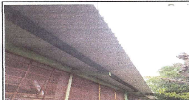
Foto 3: Sustitución de lámina, por lámina troquelada aluzinc calibre 26 Sustitución de capote de lámina para lámina acanalada Sustitución de elementos de fijación
